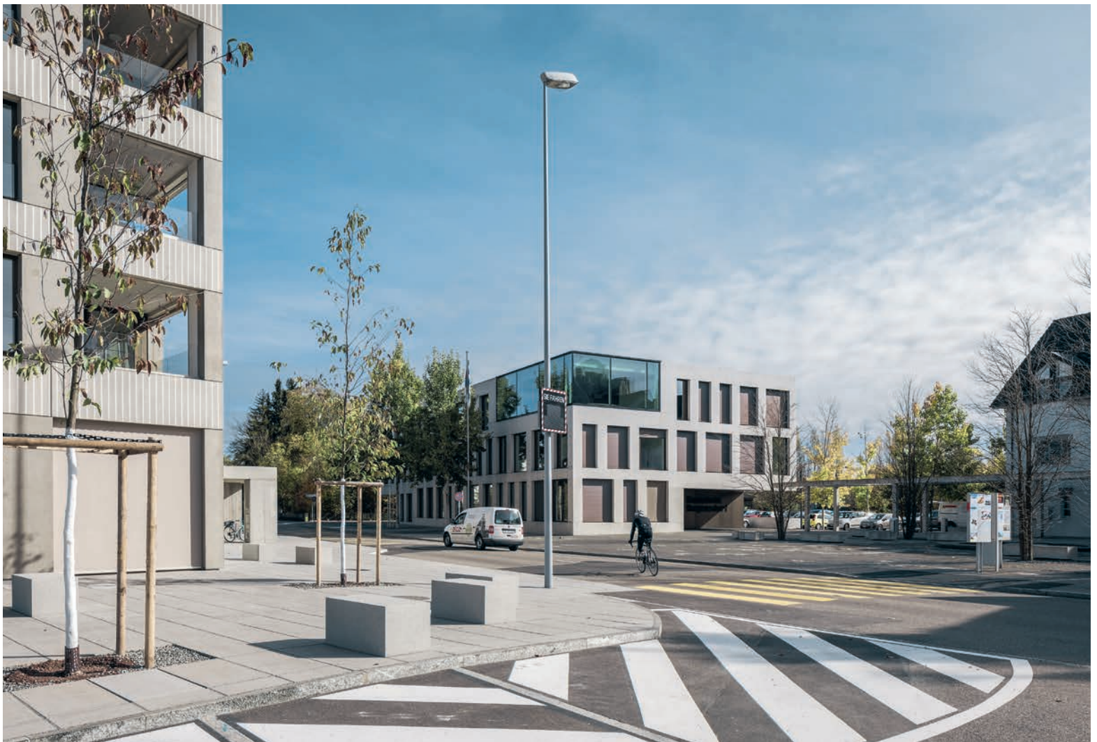
Einen Vorgeschmack auf das zukünftige Regensdorf geben heute schon die neue Gemeindebibliothek mit Wohnungen darüber (links) und das kantige Gemeindehaus.
