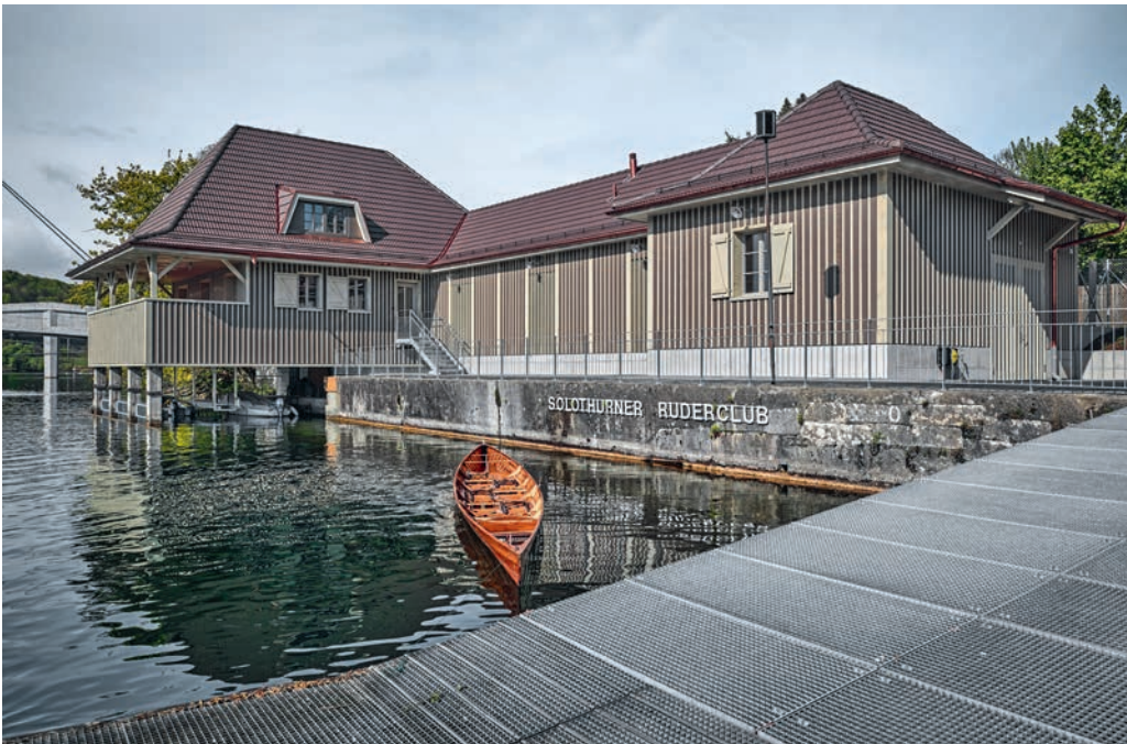
Bis auf die Stützen im Wasser ist alles neu am Ruderclub in Solothurn.
