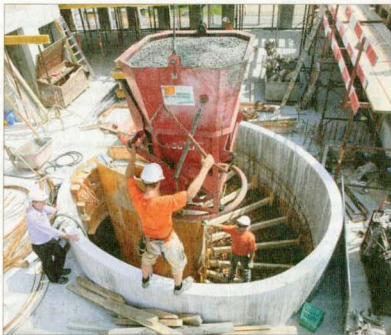
Der imposante Aufgang wird zurzeit fertiggestellt. (sim)
