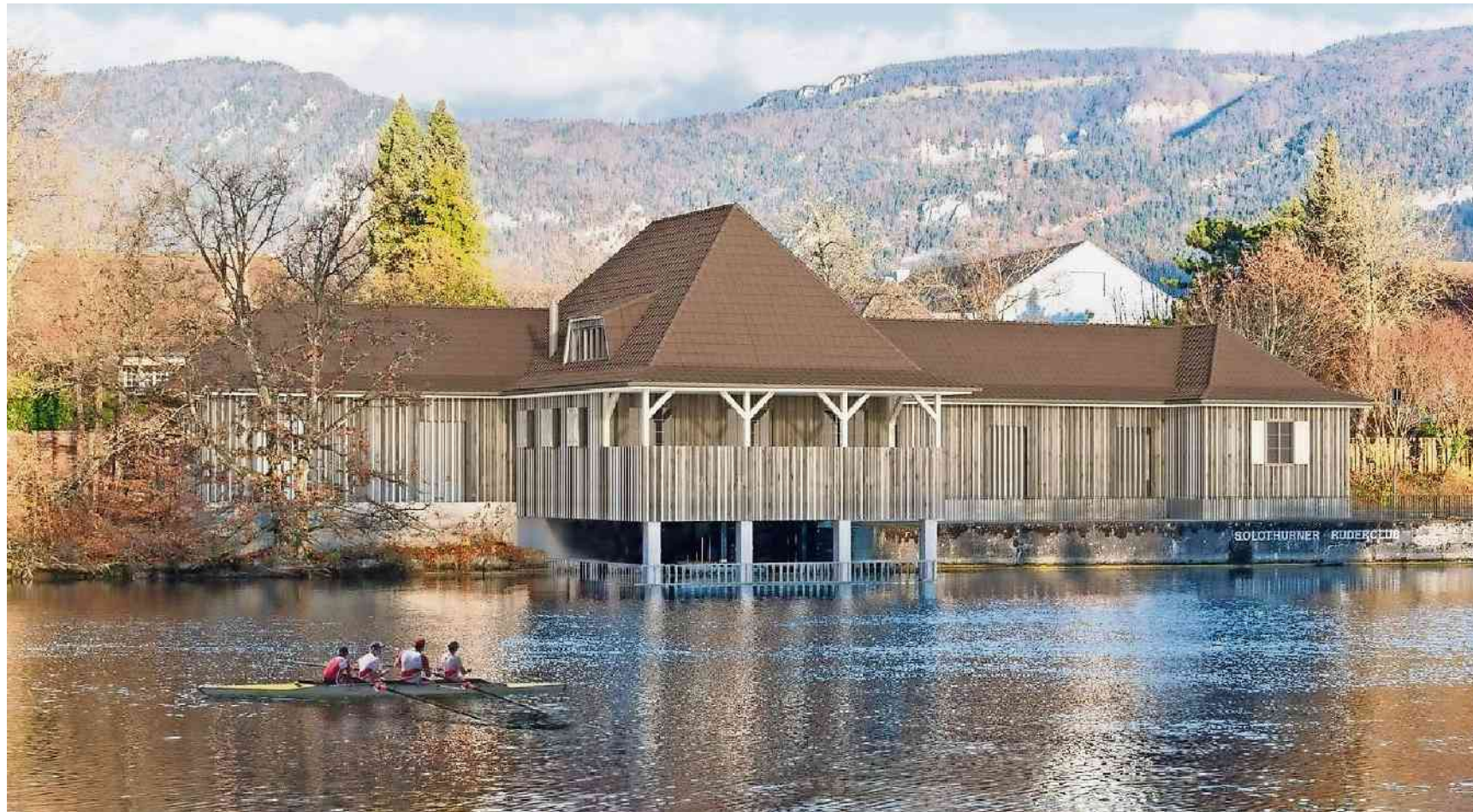
Das neue Bootshaus weist im Dach Lukarnen im Westen und Norden statt einer im Süden auf. Der Steg zum Ein- und Ausbooten (rechts nicht mehr im Bild) bleibt. ZVG
