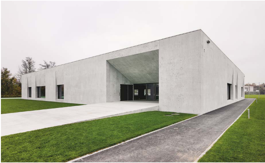
Der Eingang der Multifunktionshalle Oensingen ist nicht zu verfehlen – und das preisgekrönte Gebäude zeigt als Ganzes die geglückte Verbindung von Reduktion, Funktionalität und Materialästhetik.
